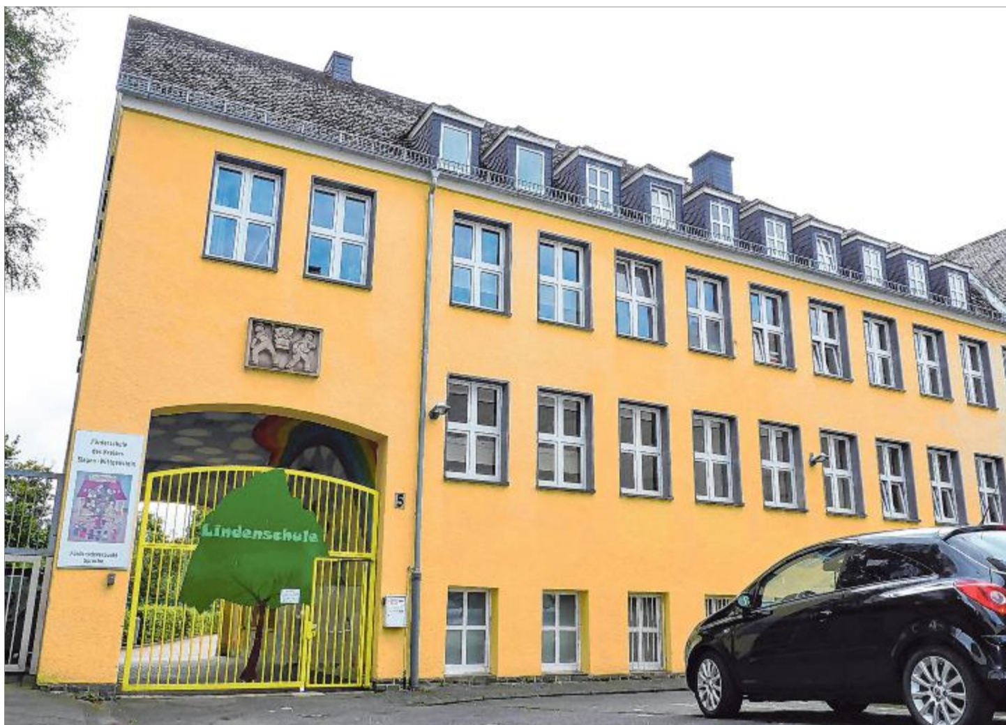
Die Lindenschule in Weidenau: Eine Kontrolle der Schulbusse am Dienstagmorgen hatte erhebliche Mängel ans Tageslicht gebracht, der Kreis als Schulträger kündigte nun an, darauf zu bestehen, dass diese schnellstmöglich behoben werden. Foto: kay
